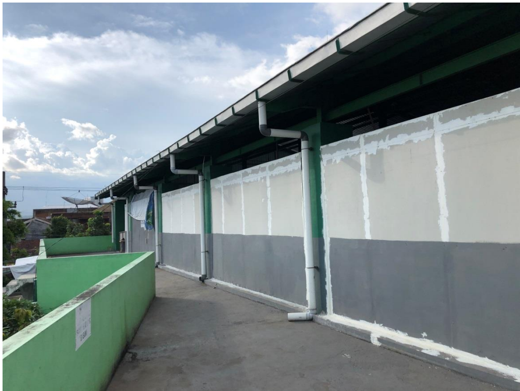
Bagian Luar dari lantai 3 Pasar Rakyat Bareng yang masih belum ada atap
